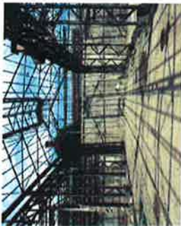
Fig. 2 - Struttura in carpenteria di acciaio degli edifici industriali preesistenti completamente recuperata nel progetto di riqualificazione
