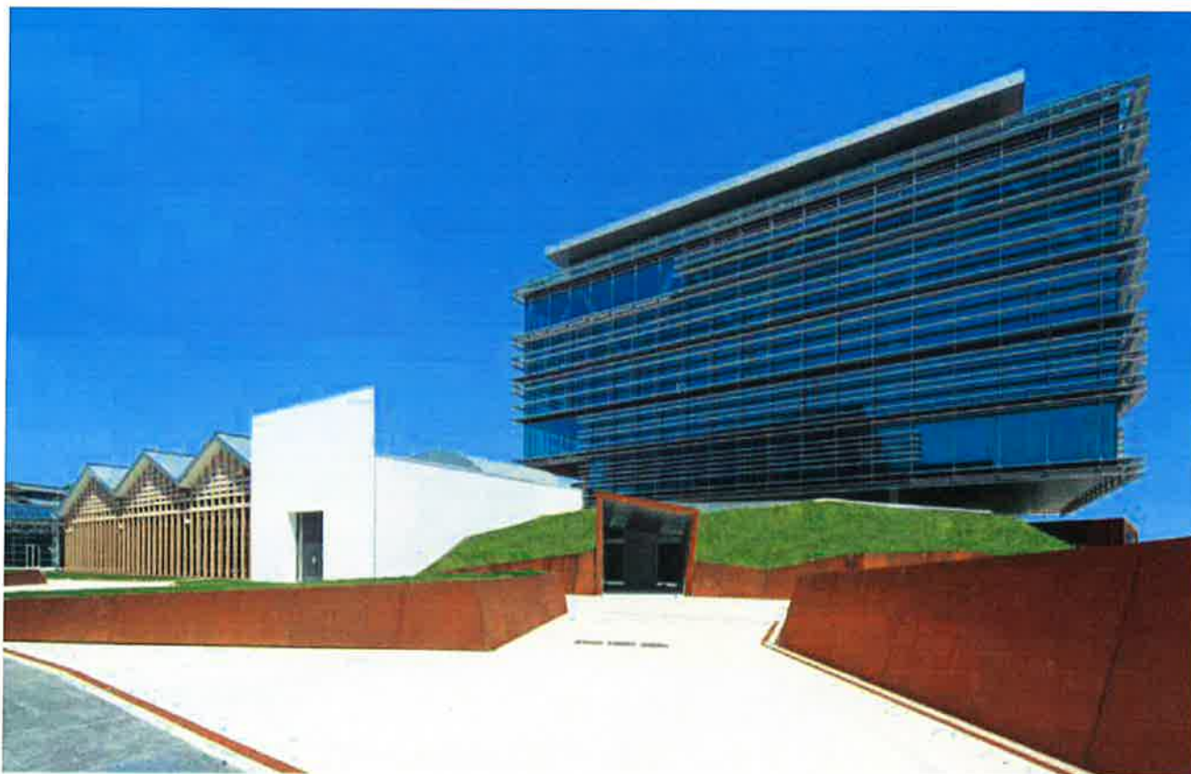
Fig. 1 - Vista complessiva dell'intervento dalla corte interna
