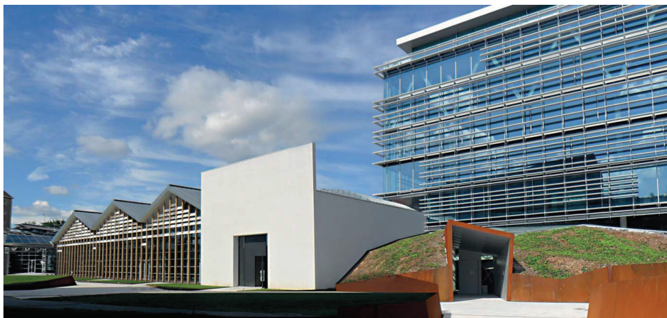
Capannoni industriali «rigenerati». Nella foto il grande complesso della Forgiatura a nord-ovest di Milano. La vecchia fabbrica milanese è stata rigenerata dai developer immobiliari Real Step Property Management, su progetto di Milano Layout, e mantenendo la destinazione d'uso produttiva dovrebbe ospitare aziende creative, del design e della moda. Finizio - pagina 45
